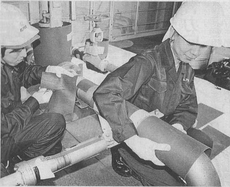
訓練用の配管模型で「Dfシート」の使い勝手を確認するアルファ技研の社員。神戸市兵庫区上庄通2、三菱重工神戸造船所
